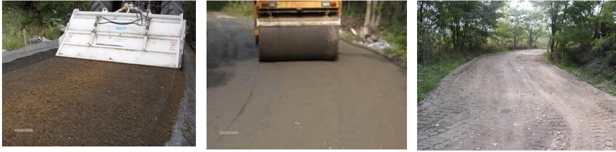
8.3.2.3. ábra: Kísérleti útszakasz építése (Csóke, Mucsi, Sík, 2008)
